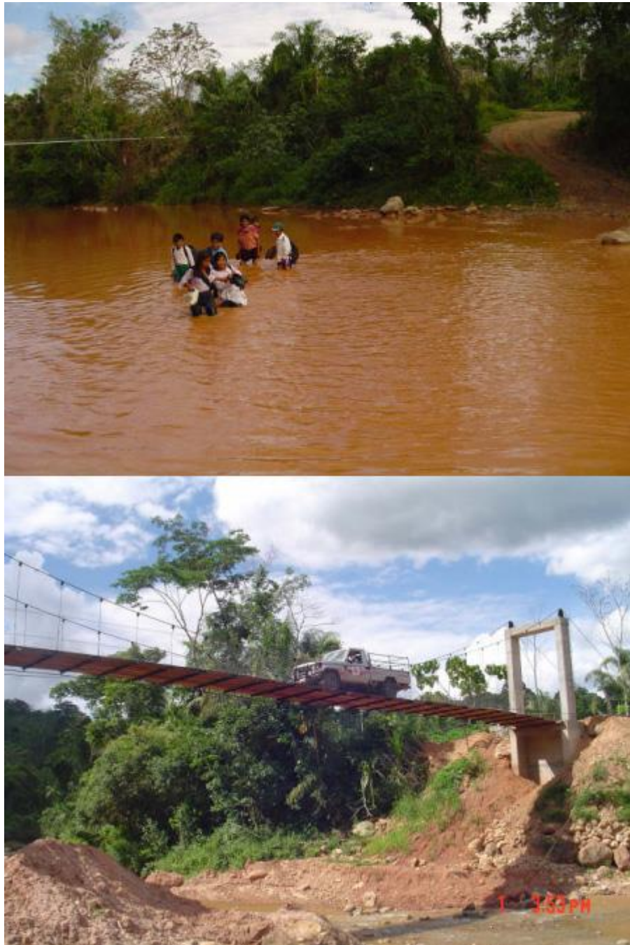
vorher (oben) und nachher: OSCAR baut Zufahrtswege und Brücken
